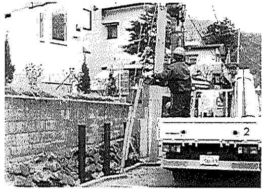
写真-8 鋼管杭打設 (B宅地)
