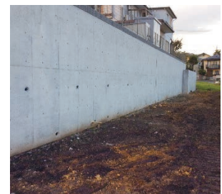
写真-8 改修後の状況②
