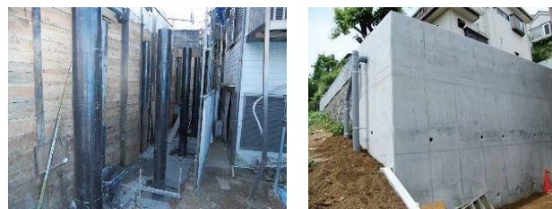
写真-2 鋼管杭打設
