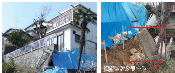
写真-1 大雨による擁壁倒壊事例
