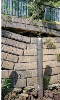
(a) 擁壁の崩壊
