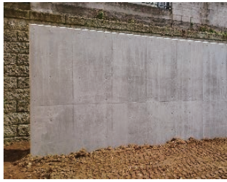
写真-4 防護壁工事（前面側）
