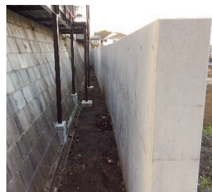
写真-7 改修後の状況①
