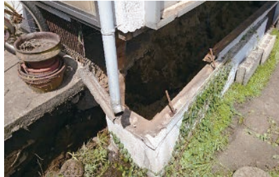
(b) 宅地地盤の沈下
